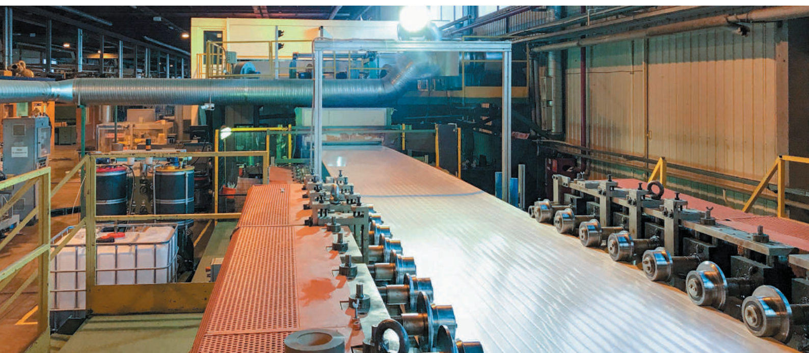
РОССИЯ, САНКТ-ПЕТЕРБУРГ. Автоматическая линия по производству стеновых и кровельных сэндвич-панелей с PIR-наполнителем
