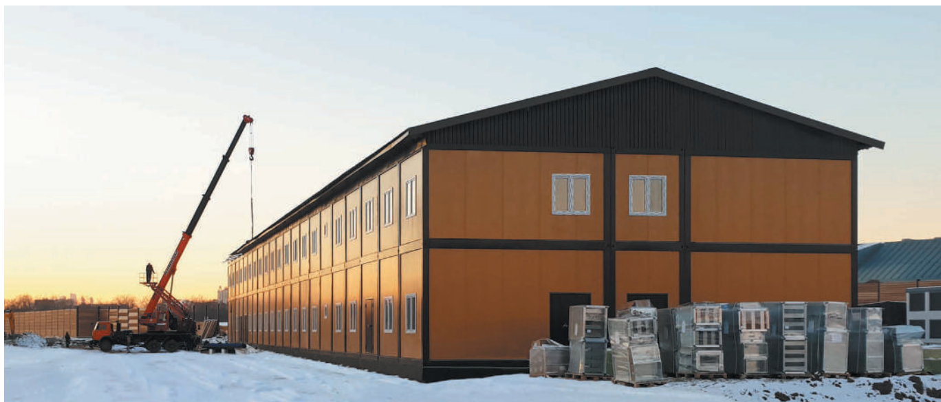
РОССИЯ, МОСКВА. Стройплощадка
