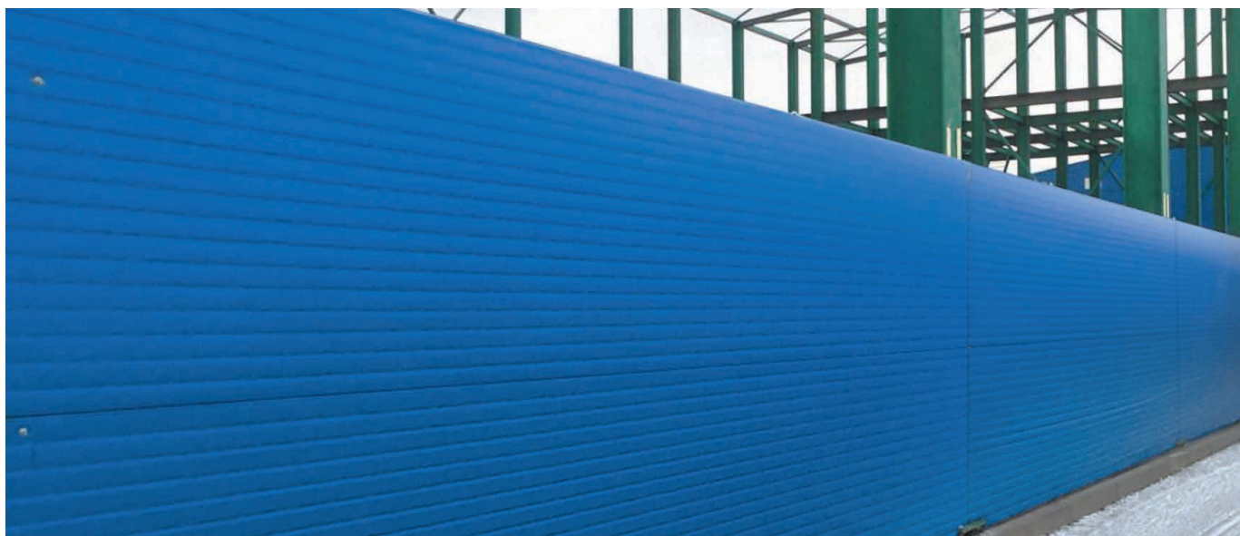
РОССИЯ, САНКТ-ПЕТЕРБУРГ. Склад низкотемпературного хранения
